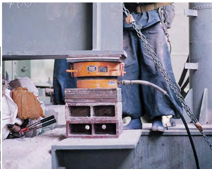
橋桁のシュー取替え用 (JFN200S3&TWA-1.3PGを使用)
