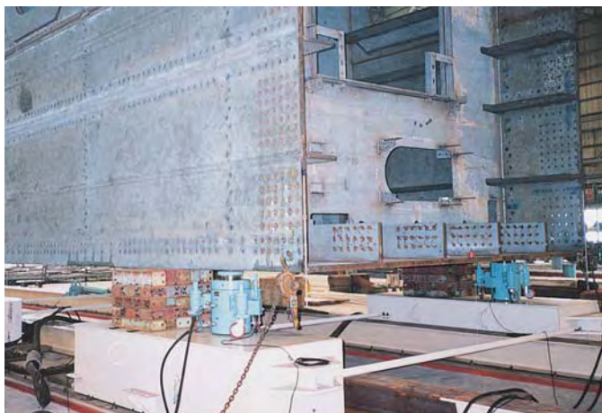
橋梁ブロックの端面加工位置微調整用 (芯出しジャッキ&電動ポンプを使用)
