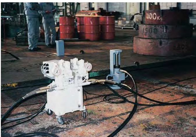
爪付パワージャッキにてジャッキアップ中
