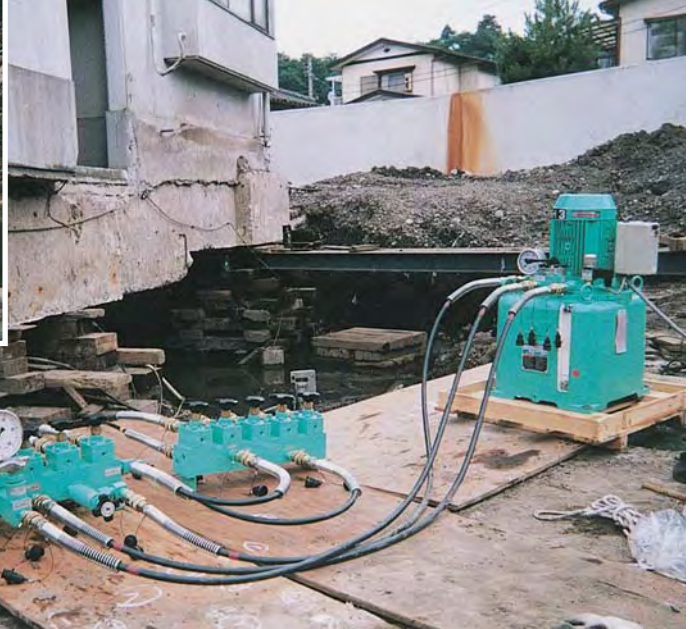
家屋のジャッキアップ用(家曳き) (E100H20&GH2ポンプを使用)
