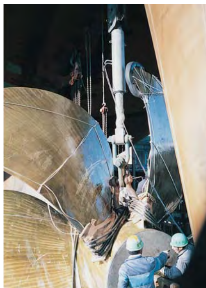
プロペラの引上げに 引張ジャッキを使用
