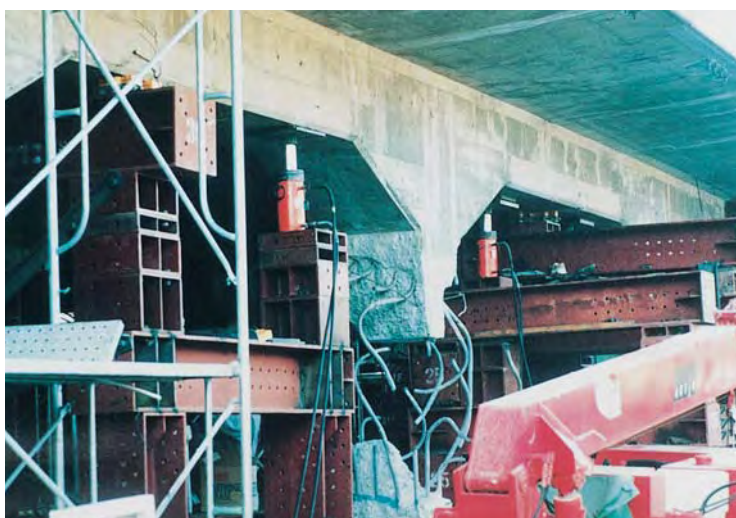
高速道路の震災復旧工事用 (500kN油圧ジャッキ&電動ポンプを使用)
