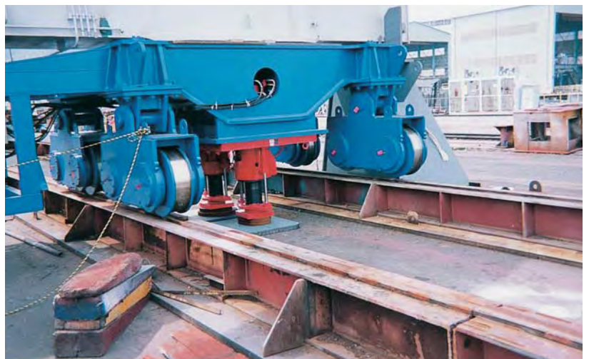
コンテナクレーンのジャッキアップ (200kN×500stパワージャッキと同調ポンプを使用)
