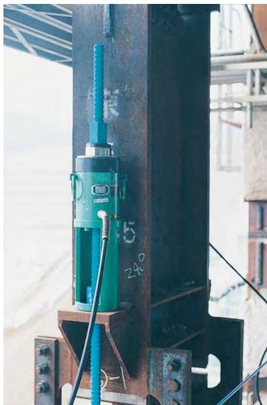
中空ジャッキにて柱の引上げ用 (EC50S7&手動ポンプを使用)
