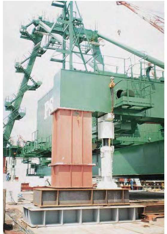
コンテナクレーンのジャッキアップ
