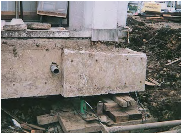
家屋のジャッキアップ用(家曳き) (E100H20&GH2ポンプを使用)
