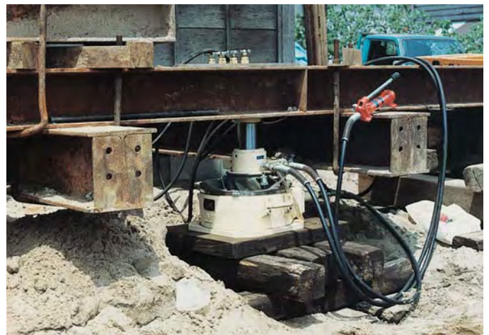
芯出しジャッキと手動ポンプを使用し微調整中
